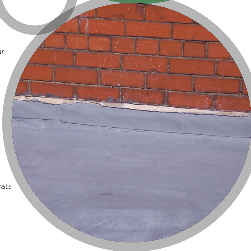
Murs de parapet
