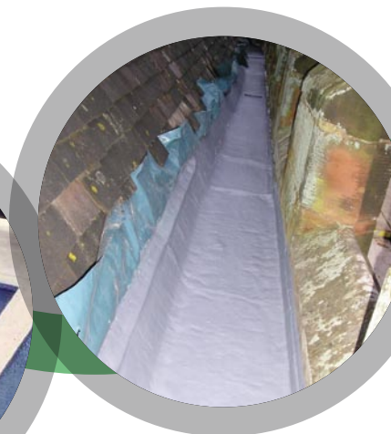
Joints de chéneaux
