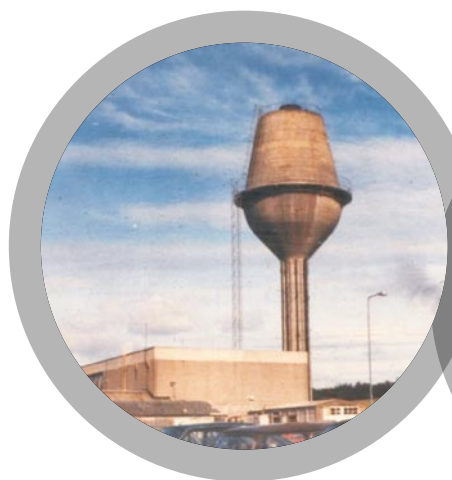
Structures en béton
