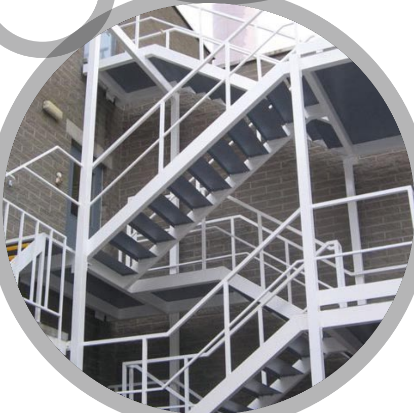
Escaliers de secours
