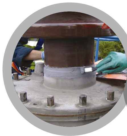
Étanchéité de joints
