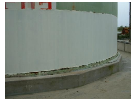
Pied de bac percé et corrodé
