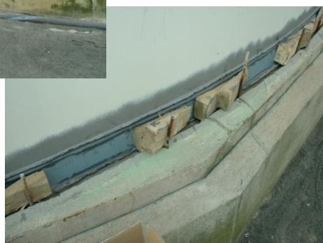
Collage des plaques au BELZONA 4341
