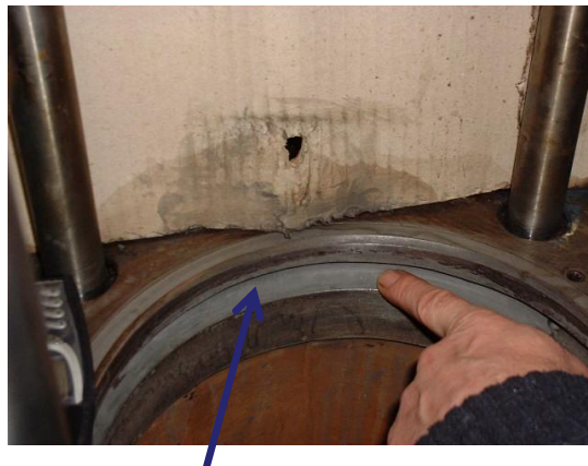
Zone réparée au BELZONA 1111 (Super Métal).
